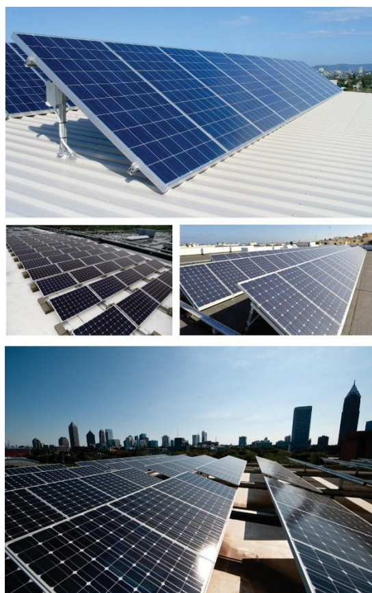
Слика 22. Могућности постављања соларних панела на равним крововима, [26]
