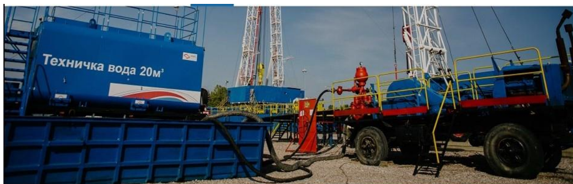
Слика 3.20 Ремонтно постројење, са покретним торњем и циркулационим системом
