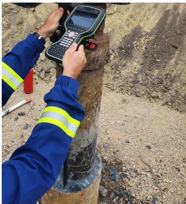
Slika 24. – Geometar (određivanje dubine sečenja)
