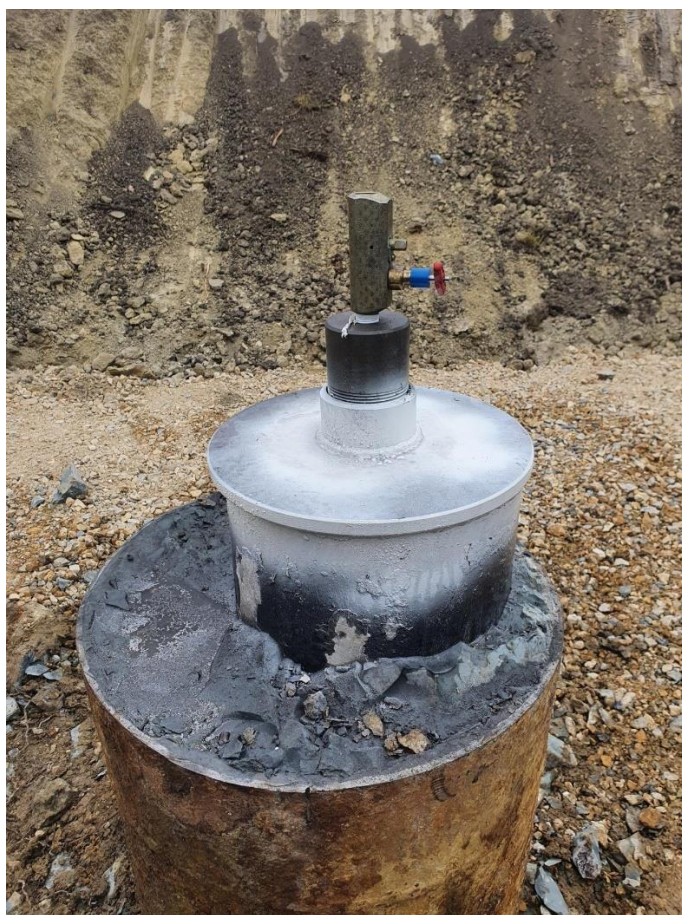
Slika 28. – Montirana pokrovna kapa
