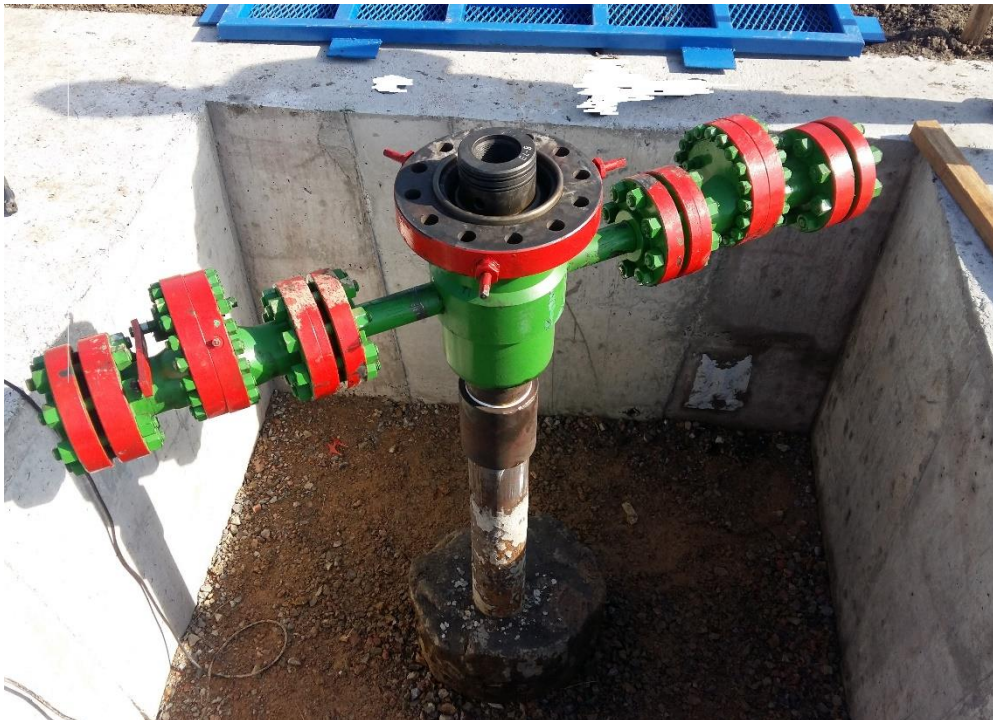
Slika 7. -Montiran kezing adapter direktnog erupcionog uređaja na bušotini
