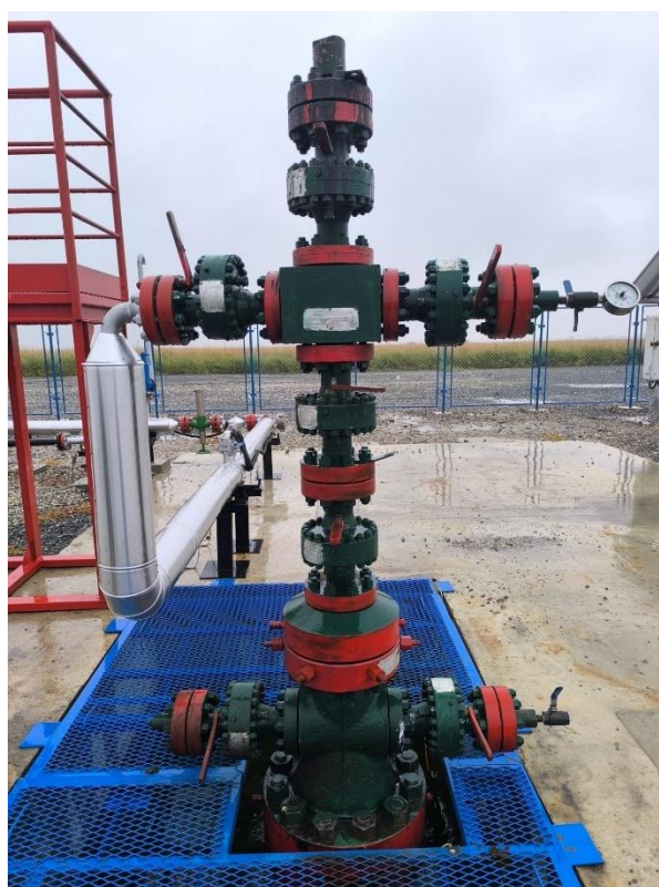
Slika 34. – Nakon remontnih radova - bušotina konzervirana i sređena lokacija
