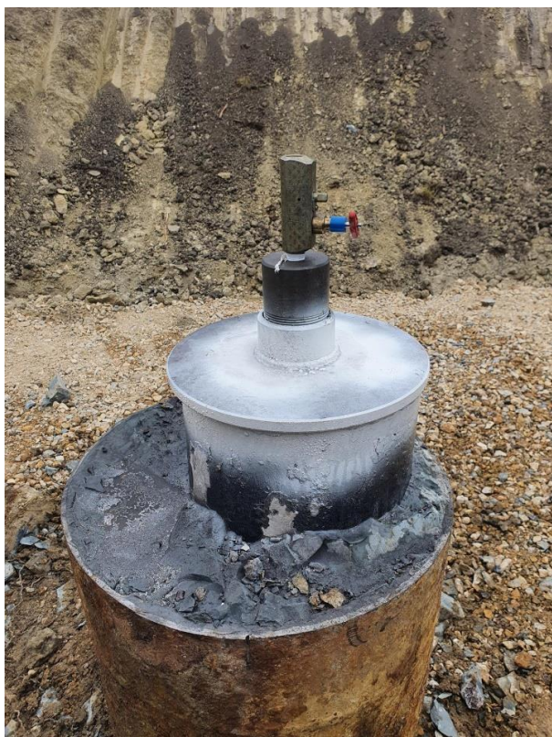
Slika 1. – Likvidaciona pokrovna kapa (zavarena ploča sa prelazom 2 7/8“, manometarskom blindom i ventilićem 1/2“)
