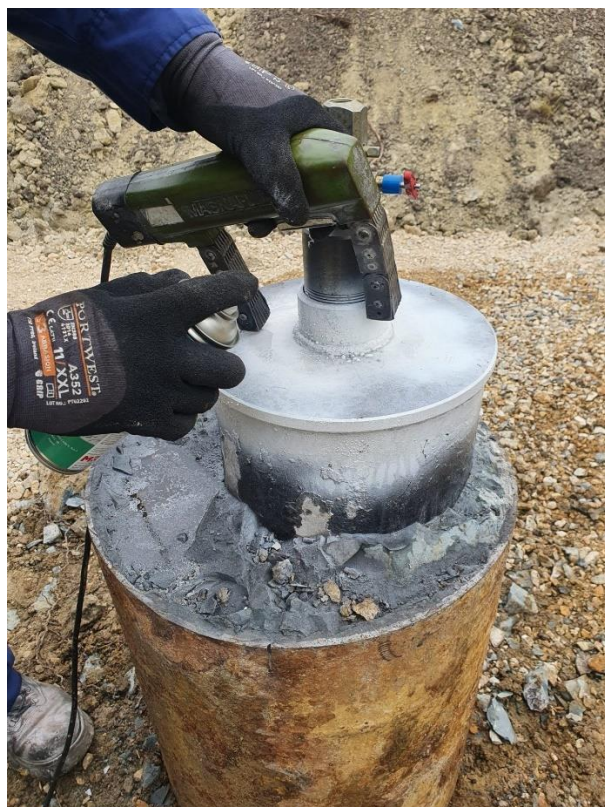
Slika 27. – NDT kontrola zavarenih spojeva
