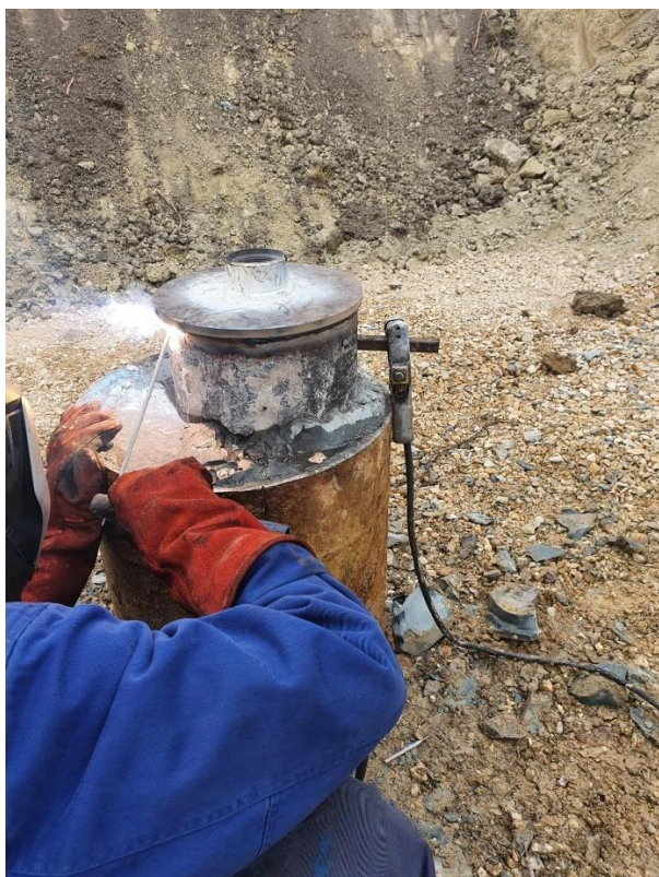
Slika 26. – Zavarivanje pokrovne kape 9 5/8“
