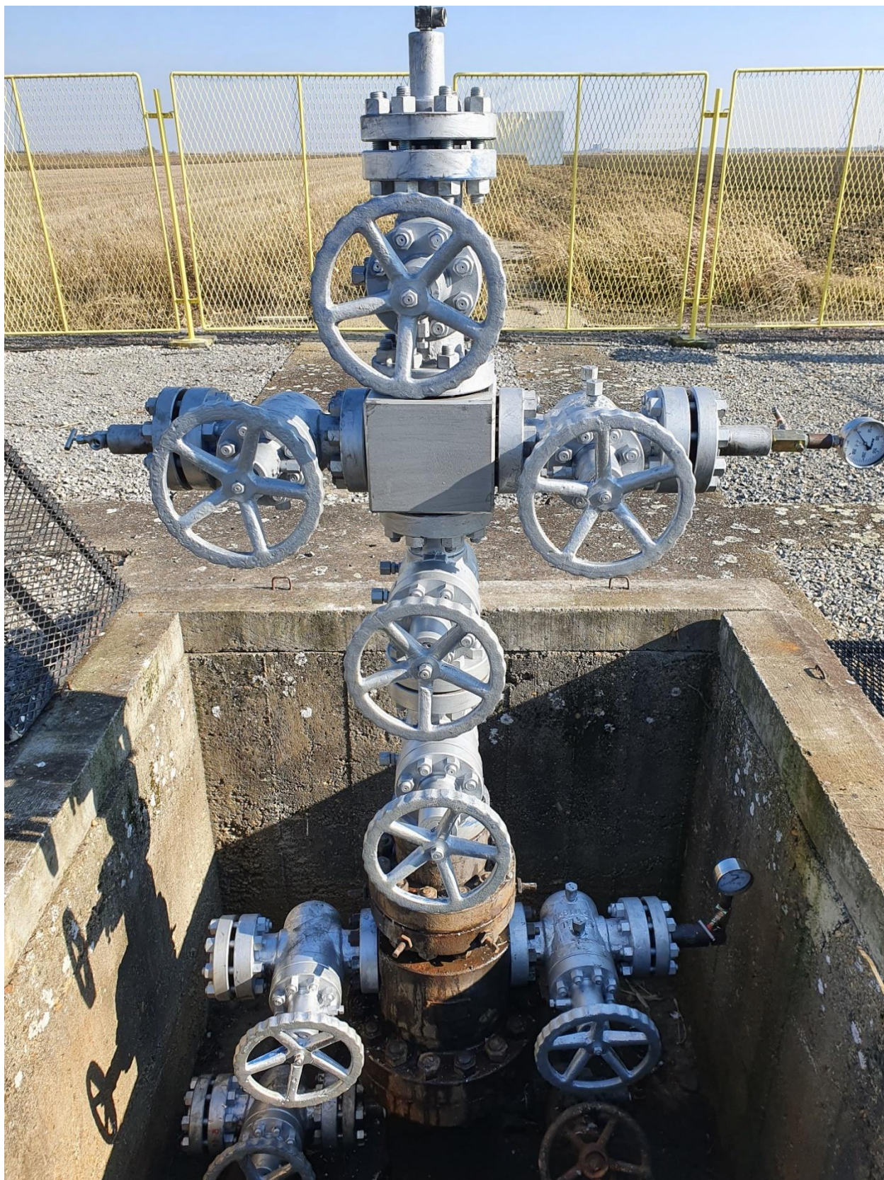
Slika 17. – Kompletan indirektan erupcioni uređaj na bušotini (Uvodna prirubnica – „bušotinska glava“, tubing adapter – „kezing adapter i gornji deo erupcionog uređaja)
