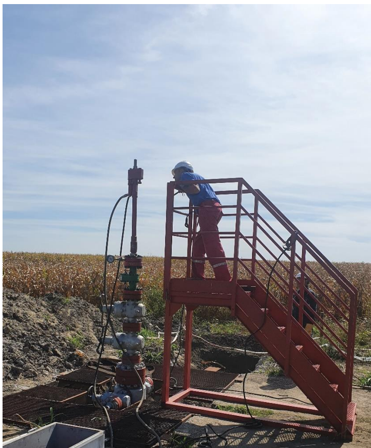
Slika 31. – Hladno bušenje ventila
