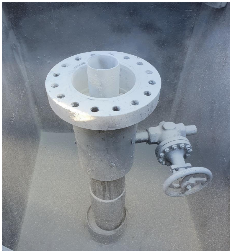
Slika 11. – Montirana uvedna prirubnica „Bušotinska glava“
