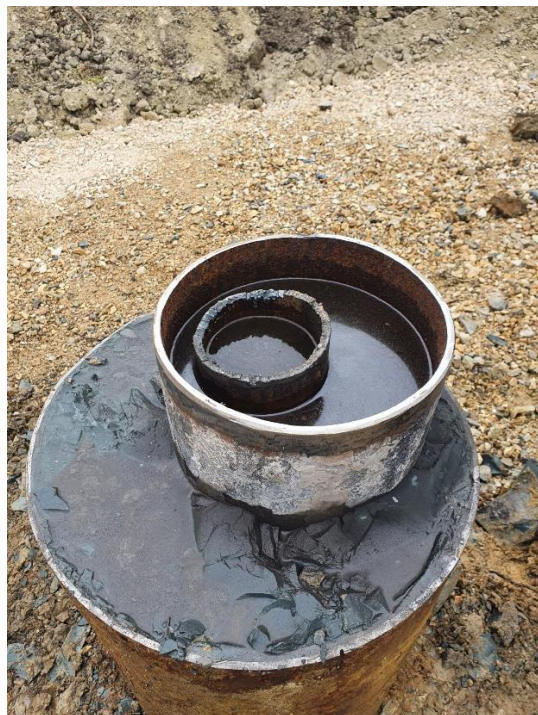
Slika 25. – Odsečene kolone na meru
