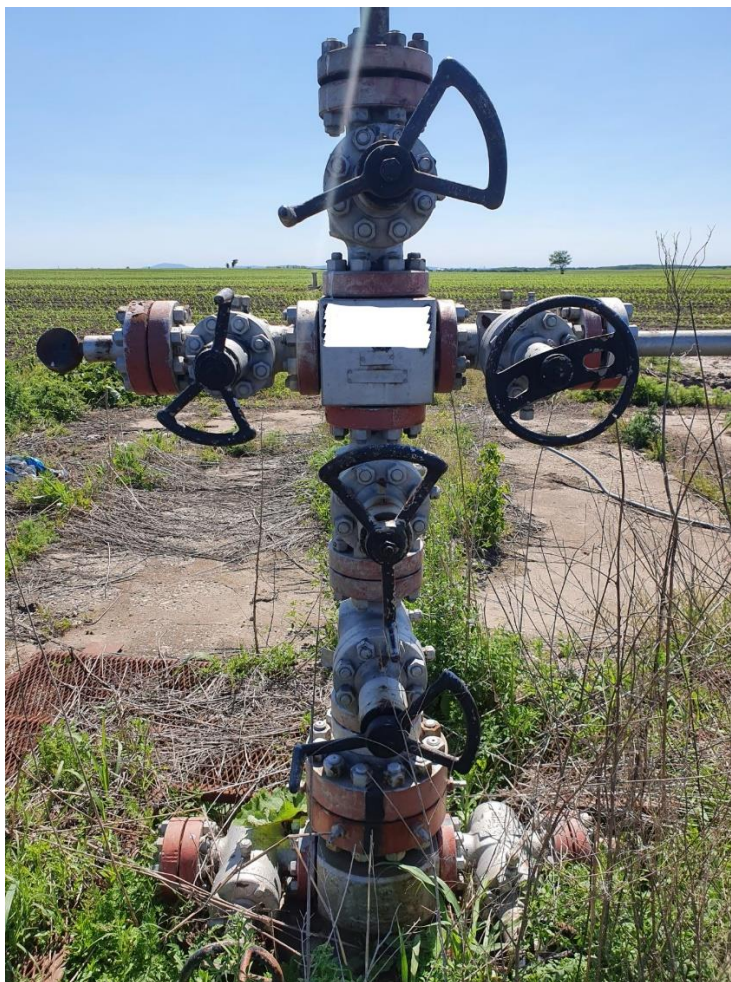
Slika 29. – Neispravan erupcioni uređaj (bušotina nije u proizvodnji)
