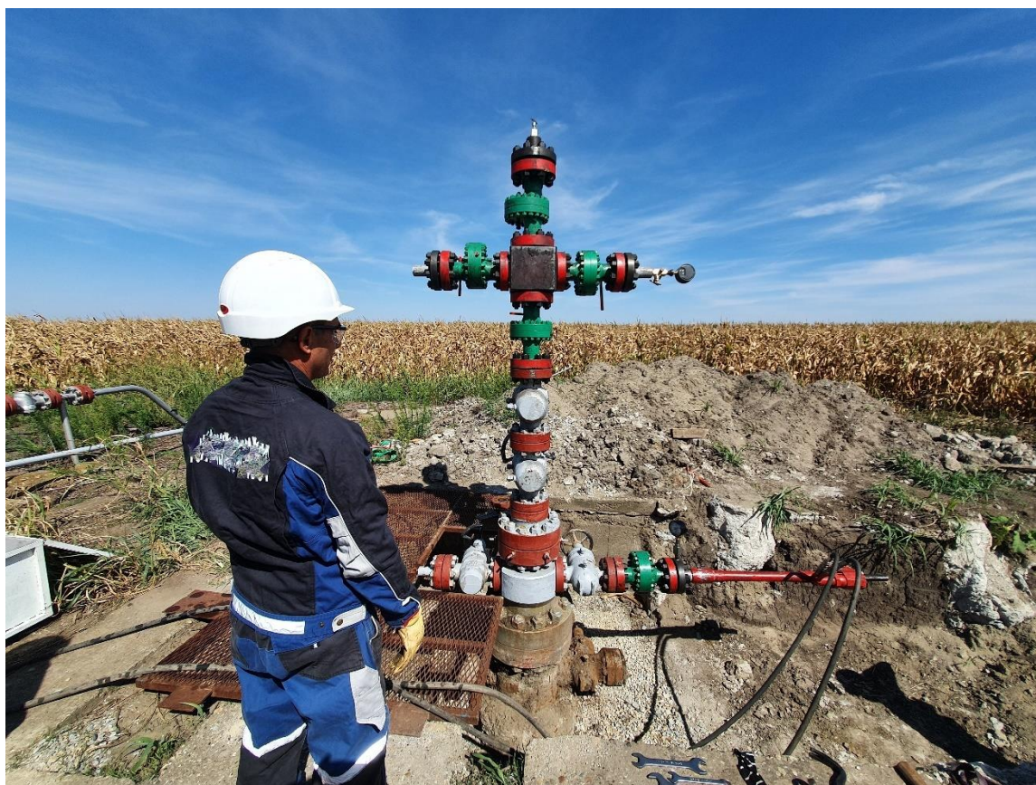
Slika 32. – Hladno bušenje neispravnog ventila na kezingu
