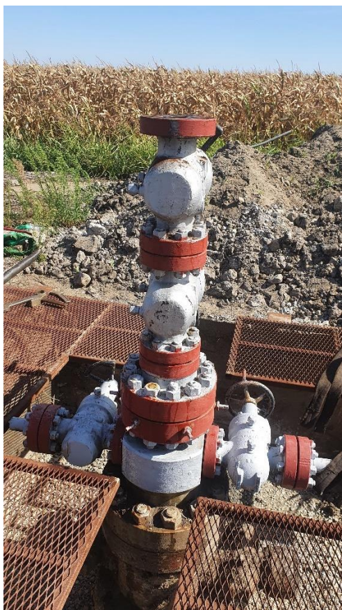
Slika 30. – Demontiran sklop ventila
