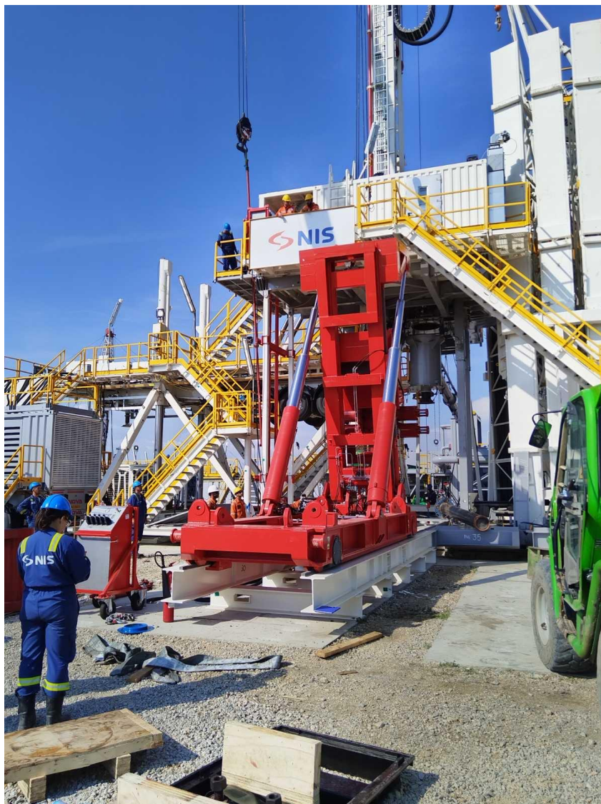
Slika 29. Montaža BOP kolica „BOP cart“ na postrojenju (Izvor: privatno)
