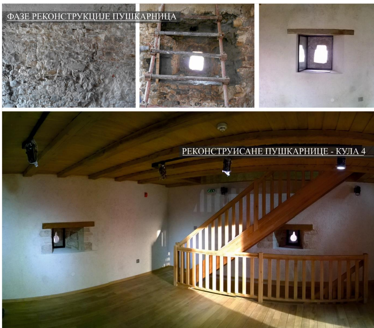
Сл.5 Изглед пушкарница у току и након реконструкције 14
