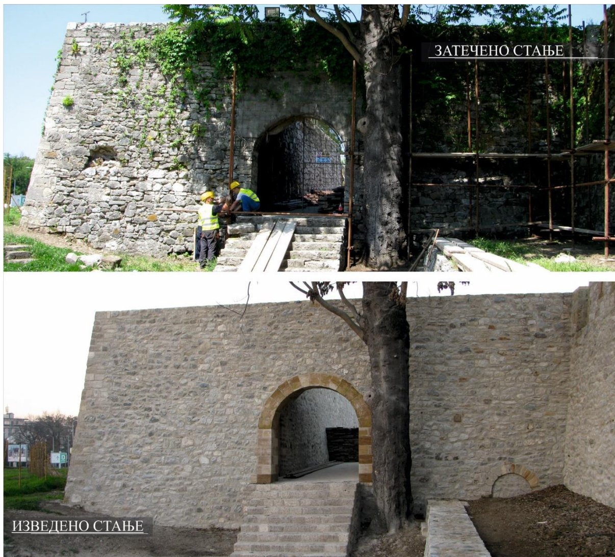
Сл. 7 Реконструкција западне улазне капије 16
