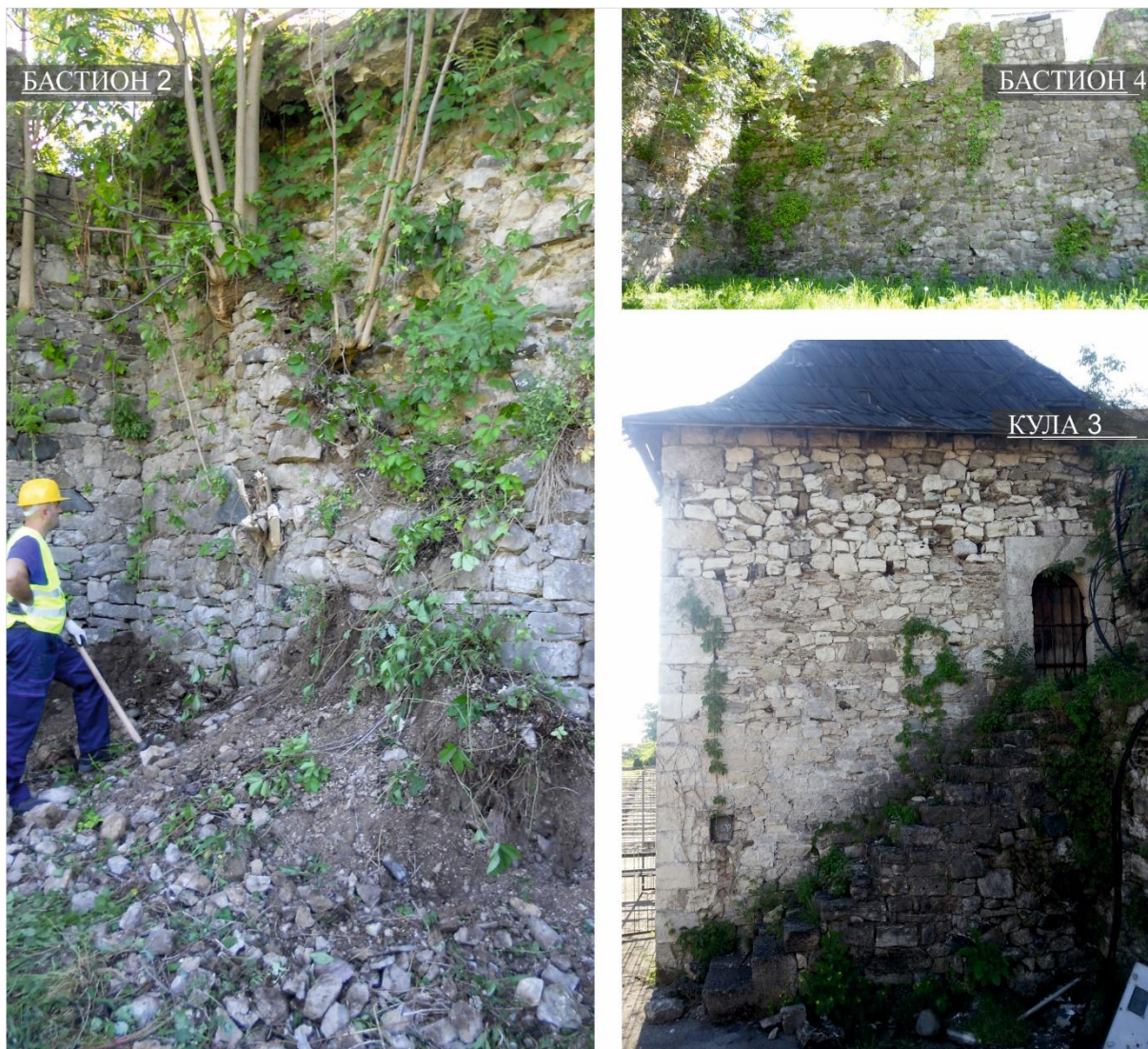
Сл. 3 Стање тврђаве прије почетка извођења радова 12
