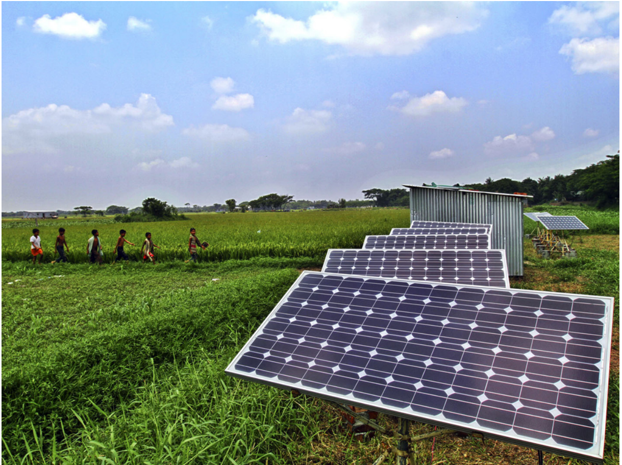
Slika 1.2: Izolovan sistem fotonaponskih panela
