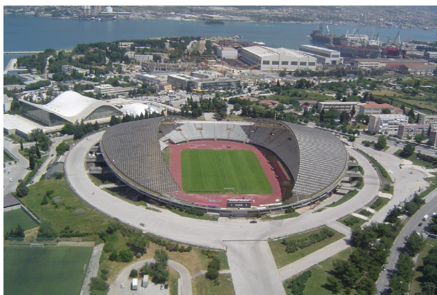
Слика 77. Стадион у Сплиту, Хрватска. Кровна конструкција из два сегмента материјализована употребом Меро система просторне решетки. Фотографије власништво министарства културе Републике Хрватске.
