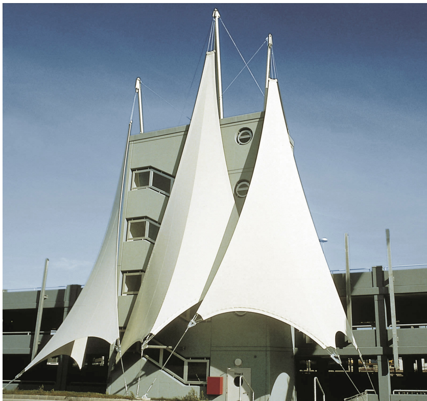
Слика 114. Комплексни текстилни кровни покривач од ХДПЕ (полиетирена високе густине). Непознат аутор фотографије.
