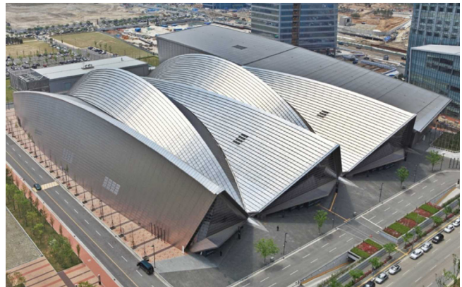
Слика 54 десно. Просторна решетка на комплексној аморфној форми. Фотографија власништво ЛФ-БЈМБ ( Bolted Joint Modular Building System ).
