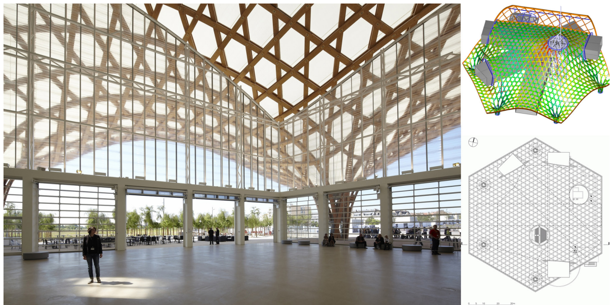
Слика 123. Процедурално моделована сложена конструкција Помпиду центра у Мецу, Француска. Преплетена структура од ламелираног дрвета пројектована по модуларној методологији са акцентом на једноставном и ефикасном генерисању документације за потребе фабрикације елемената. Фотографија и цртежи власништво Шигеру Бан архитектонског бироа ( Shigeru Ban Architects ).
