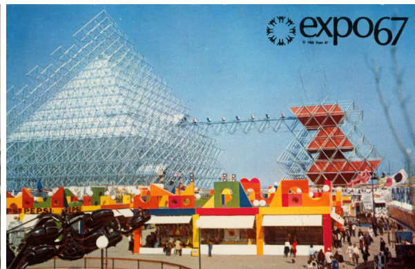
Слика 12 лијево. Модуларна вишеслојна просторна решетка павиљона “Човјек произвођач” на Експо сајму у Монтреалу 1967. године. Фотографија власништво Камлех Парик архитектонске асоцијације ( Kamlesh Parikh, Architectural Association Photo Library ).
