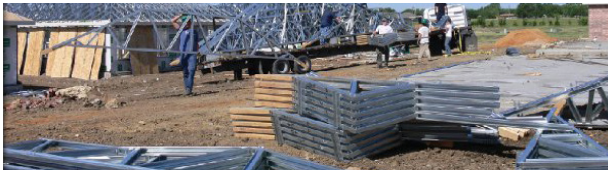
Слика 53. Монтажа просторне решетки на тлу поред објекта. Наредна фаза је подизање једном од описаних метода. Фотографија власништво Фридом Стила ( Freedom Steel Co. )
