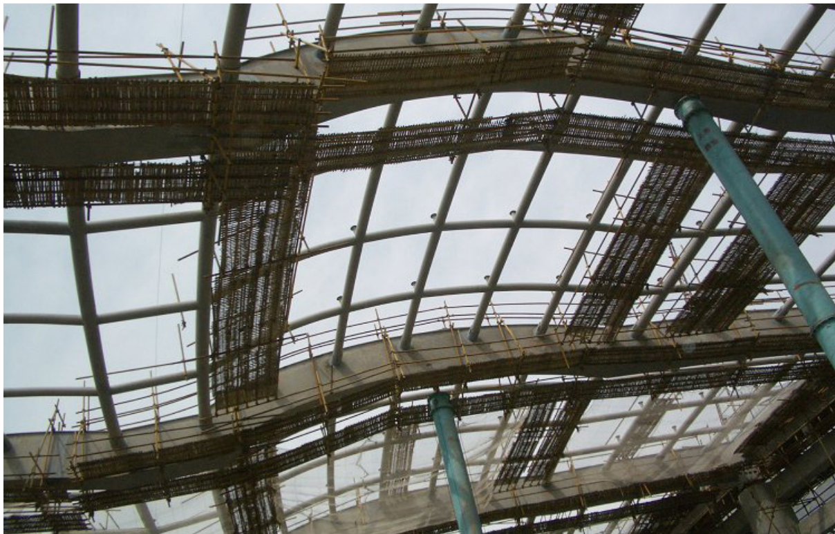
Слика 97. Бетонска просторна решетка спортске дворане у изградњи. Фотографија власништво “Shanghai SSRF Space Frame Steel co.” компаније.
