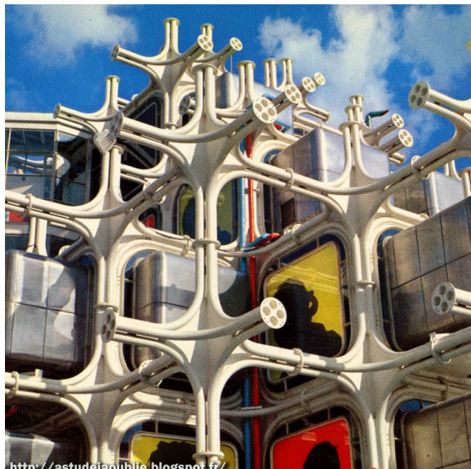
Слика 16 лијево. “Takara Beautilion” павиљон на Експо сајму 1970. године у Осаки, Јапан. Састављен од шестокраких круто спојених модула формира кубичан тродимензионални растер. Фотографија власништво Ричард Роналд архитектонске асоцијације (Richard Ronald, Architectural Association Photo Library).
