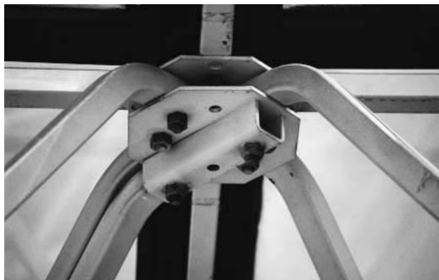
Слика 84 лијево. Карактеристични тродимензионални детаљ Униструт система спајања штапова са плочастим елементима у чворним тачкама просторне решетке. Аутор цртежа непознат.
