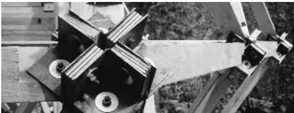
Слика 23. Спој штапова у чвору конструкције на кући Нусатсум. Фотографија дјело Р. Г. Сатервајта (R. G. Satterwhite).
