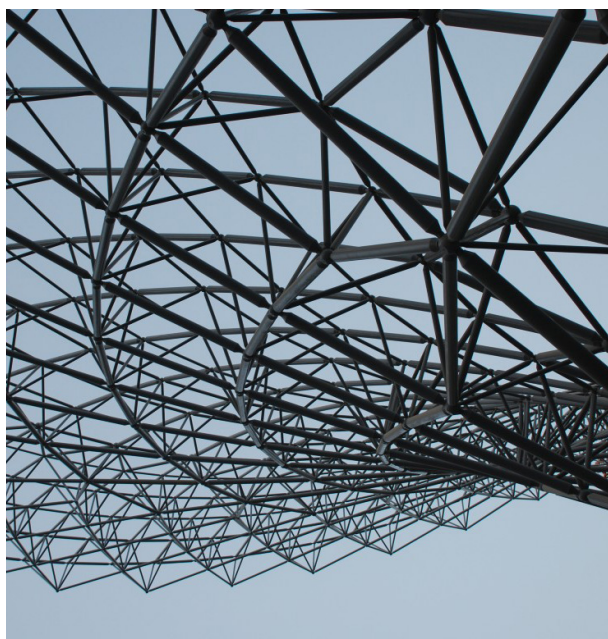
Слика 129 лијево. Дванаест стубова око централне зоне који формирају облик лијевка. У основи квадратни стубови на пола висине равају се у оштре лучне решеткасте конструктивне елементе. Фотографија власништво Меро ТСК компаније ( Mero TSK ).
