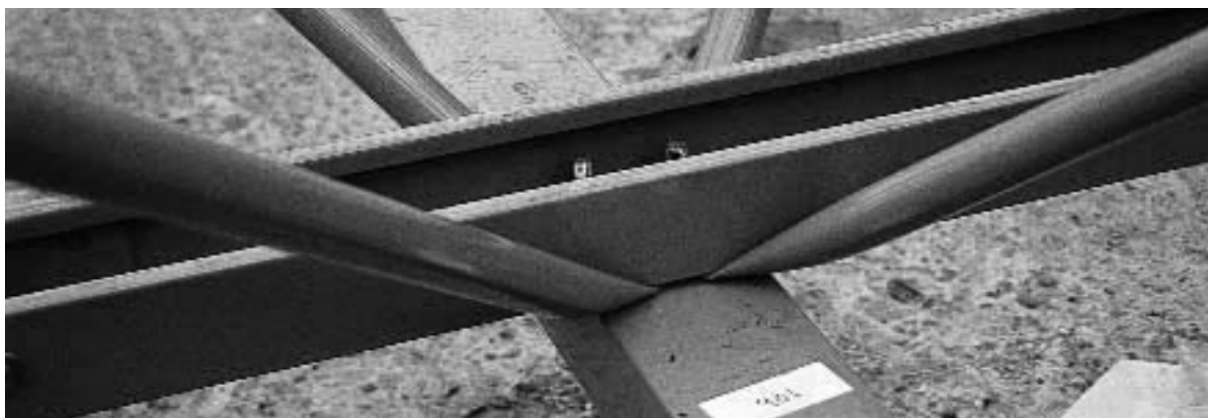
Слика 86. Карактеристичан Харли Кондер тип 80 спојни систем у чвору решетке. Аутор фотографије Џон Чилтон ( John Chilton ).
