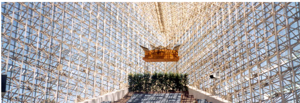
Слика 26. Ентеријер Кристалне катедрале са зидовима и кровом од просторне решетке, изузетно прозрачне и динамичне атмосфере. Посебна пажња посвећена заштити конструкције од прекомјерног загријавања које изазива контракцију и експанзију. Фотографија дјело Н. М. Т. Џексона ( N. M. T. Jackson ).
