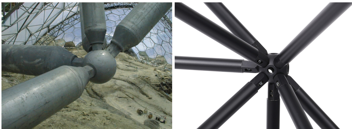
Слика 76. Примјери изведених Меро систем просторних решетки на великим и малим пројектима. Слика лијево приказује један типични спој штапова у чворном елементу на пројекту Бисфера 2 у Аризони, САД. Фотографије власништво Маро ТСК компаније (Mero TSK).
