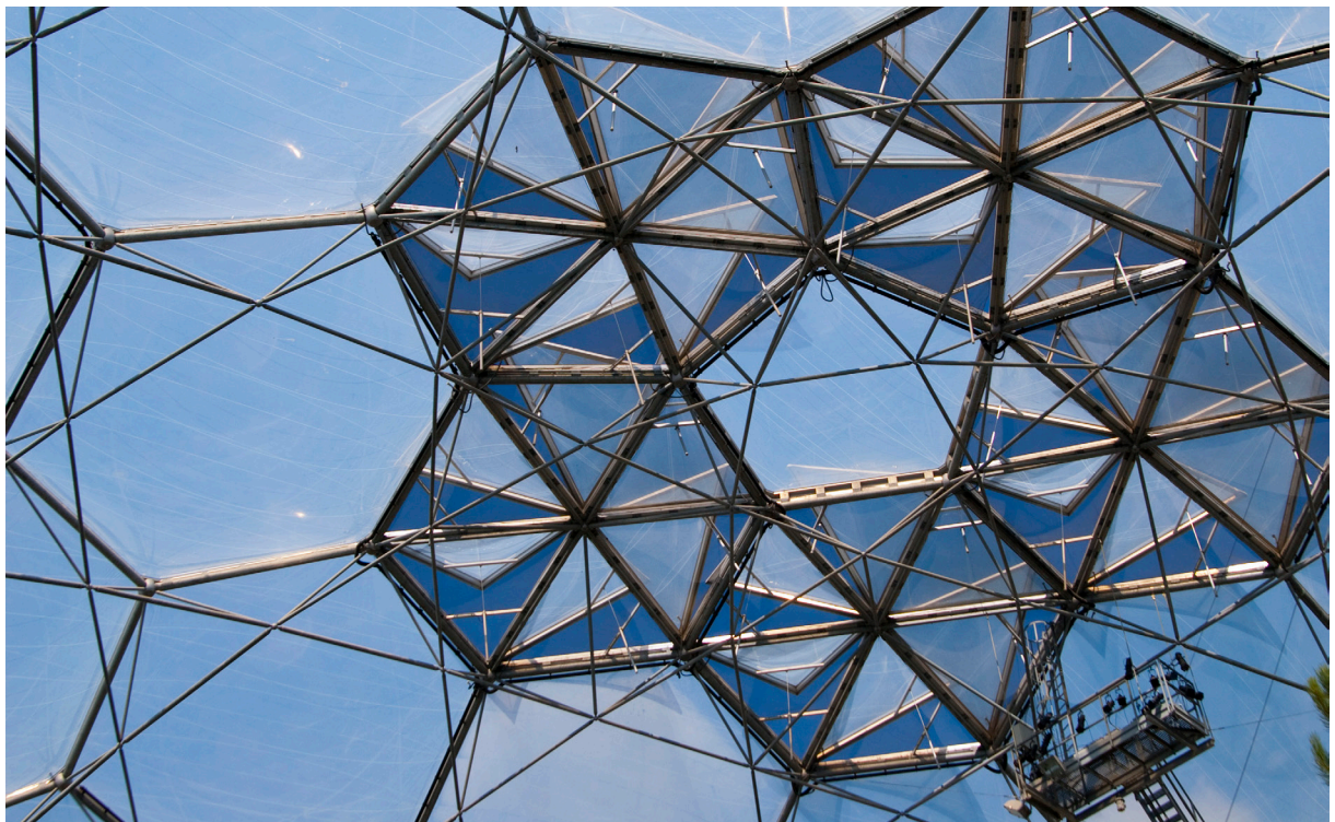
Слика 144. Процес монтаже и подизања кровног покривача. Постављен је након завршеног подизања просторне решетке. Фотографија власништво Гимшоу Архитекти ( Grimshaw Architects ) студија.
