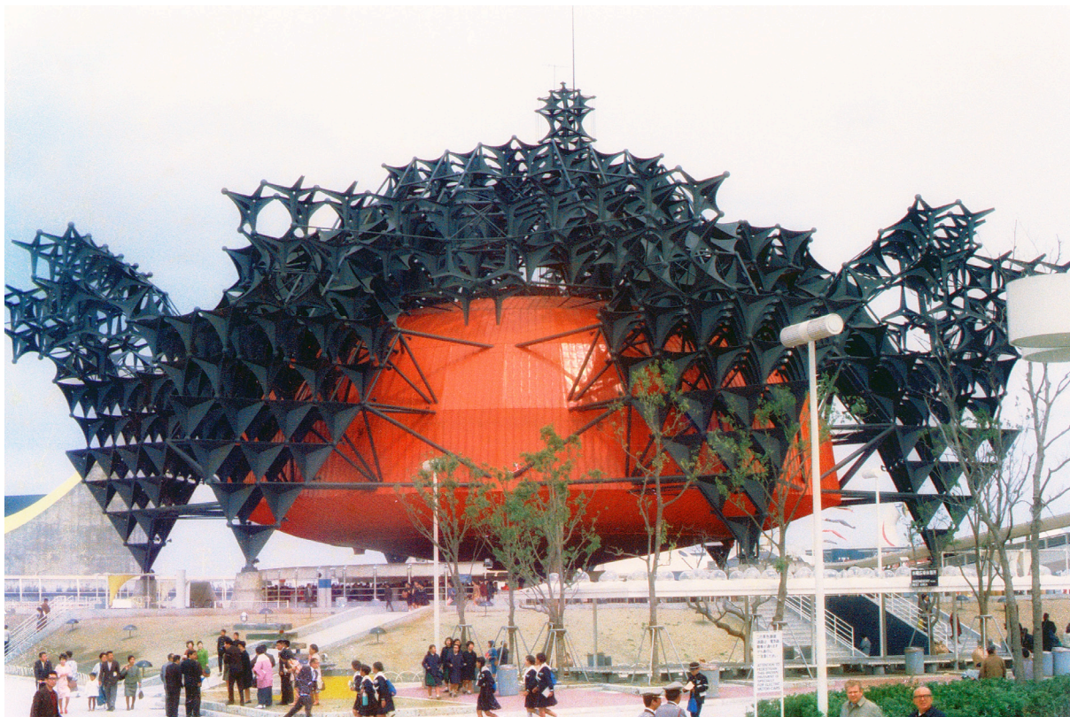
Слика 15. Тошиба ИХИ павиљон на Експо сајму 1970. године у Осаки, Јапан. Састоји се од тетраедалних модула које је пројектовао Кишо Курокава. Фотографија власништво Денис Кромтон архитектонске асоцијације ( Dennis Crompton, Architectural Association Photo Library ).
