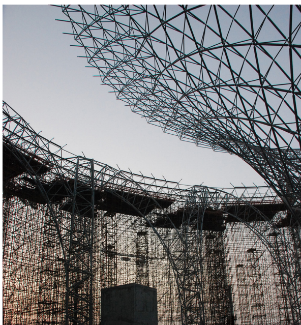
Слика 129 лијево. Дванаест стубова око централне зоне који формирају облик лијевка. У основи квадратни стубови на пола висине равају се у оштре лучне решеткасте конструктивне елементе. Фотографија власништво Меро ТСК компаније ( Mero TSK ).
