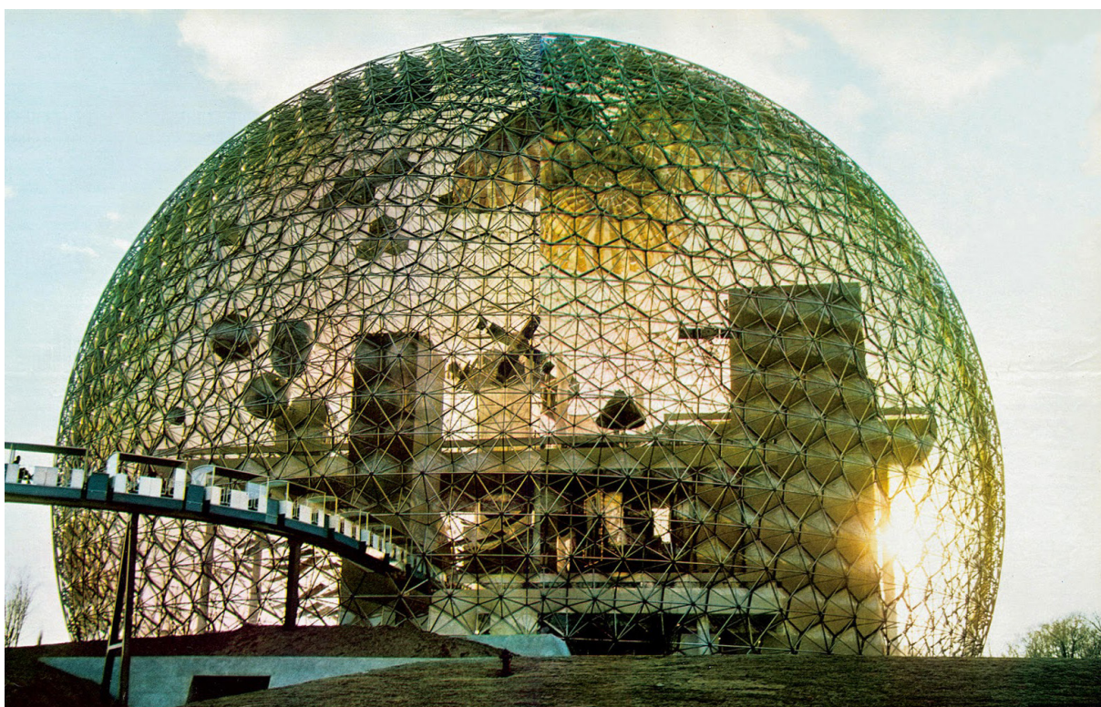
Слика 66. Пројекат Ричарда Бакминстера Фулера, 3/4 лопте пречника 76\text{ m} . Конструисан за Експо сајам 1967. у Монтреалу, Канада. Геодетска купола са просторном решетком. Фотографија Кејстон Хултон (Keystone Hulton).
