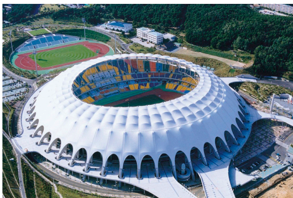
Слика 111 лијево. Мембрански текстилни покривач од ПТФЕ (тефлон са слојем стаклених влакана) на примјеру спортског стадиона. Фотографија Сатоши Наканое ( Satoshi Nakanoue ).
