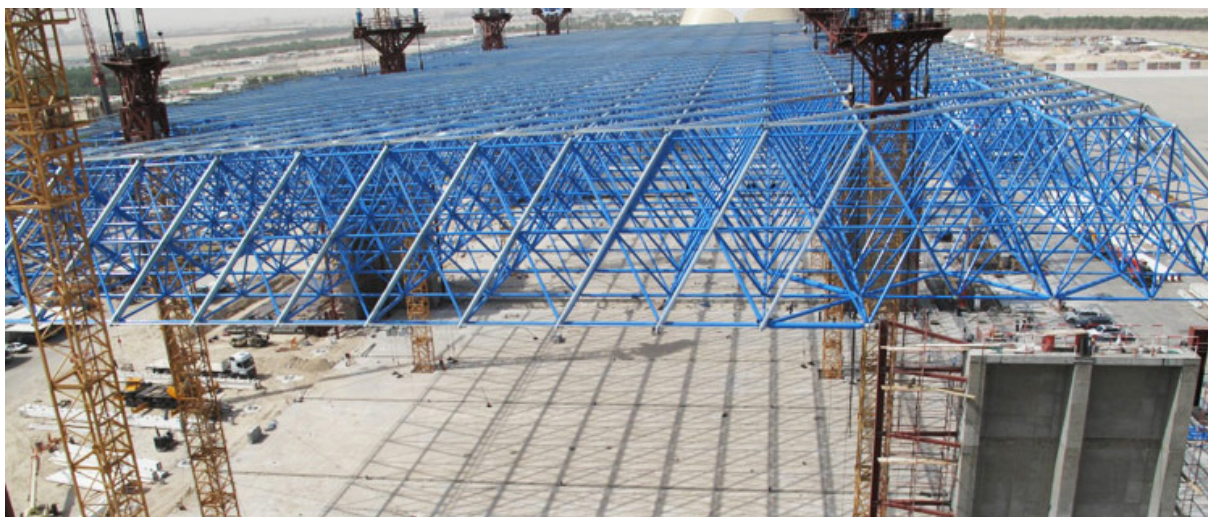
Слика 53. Подизање двослојне просторне решетке помоћу хидрауличних дизалица. Фотографија власништво Ал Фарокија ( Al Farooqi Engineering Consultants ).
