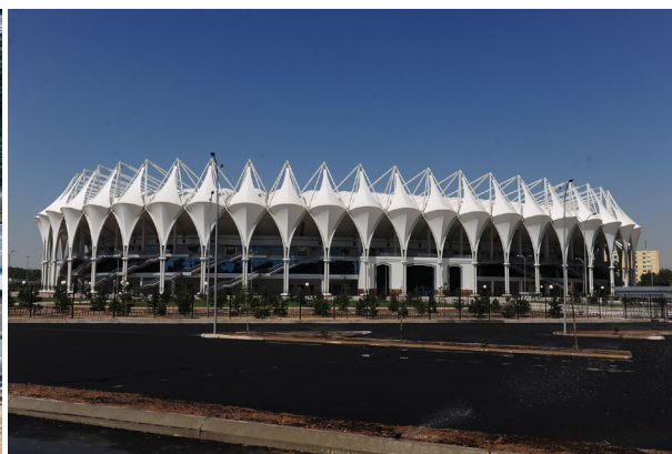
Слика 111 лијево. Мембрански текстилни покривач од ПТФЕ (тефлон са слојем стаклених влакана) на примјеру спортског стадиона. Фотографија Сатоши Наканое ( Satoshi Nakanoue ).
