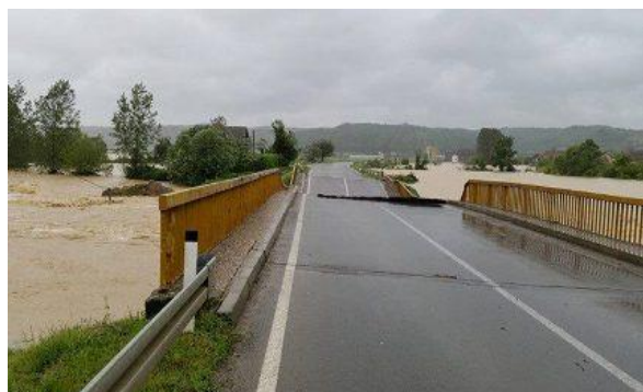
Slika 2. Direktna oštećenja saobraćajne infrastrukture nastala izlivanjem Tamnave 2014. godine (preuzeto sa sajta opštine Koceljeva - koceljeva.gov.rs)
