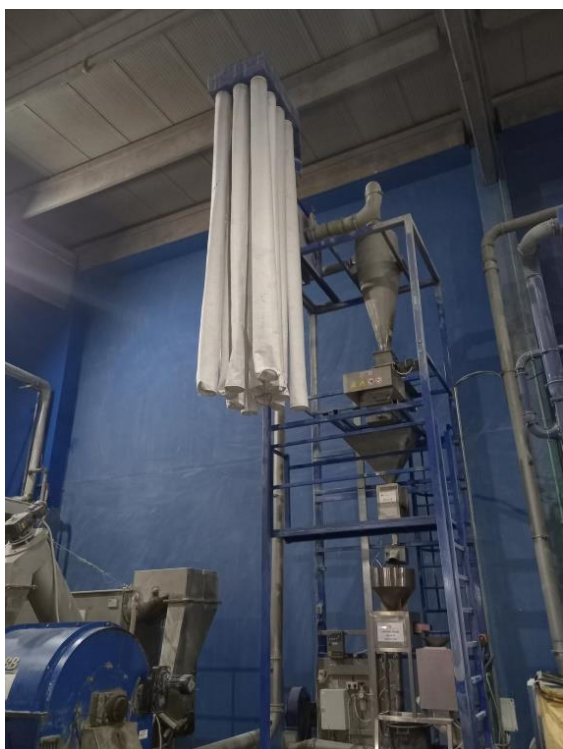
Slika broj 4.16. Vrećasti filteri nakon ugradnje
