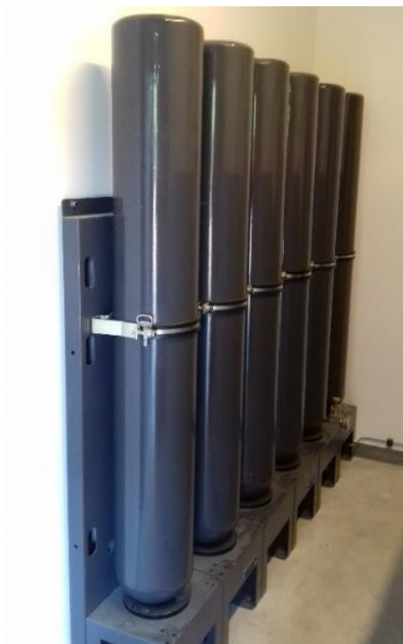
Slika 42. „Banka vazduha“ fiksirana za zid, [7].
