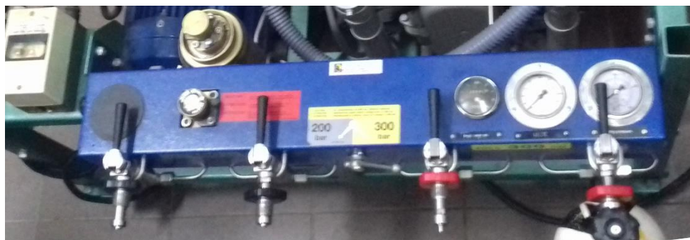
Slika 39. Ventili za punjenje „na kipu“, sa po dva ventila 200 bar (crni) i 300 bar (crveni).
