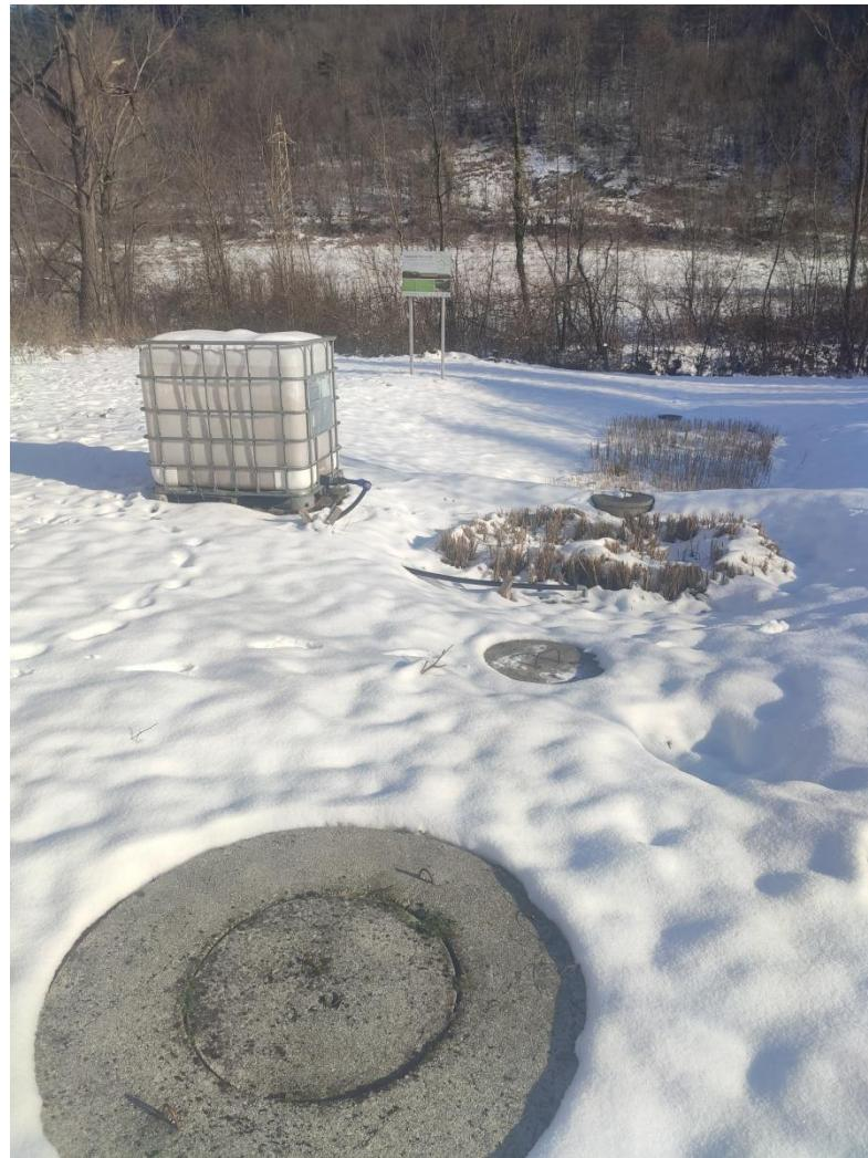
Slika 37. Izgled biljnog uređaja u zimu 2020-te godine tokom obrade sintetske otpadne vode
