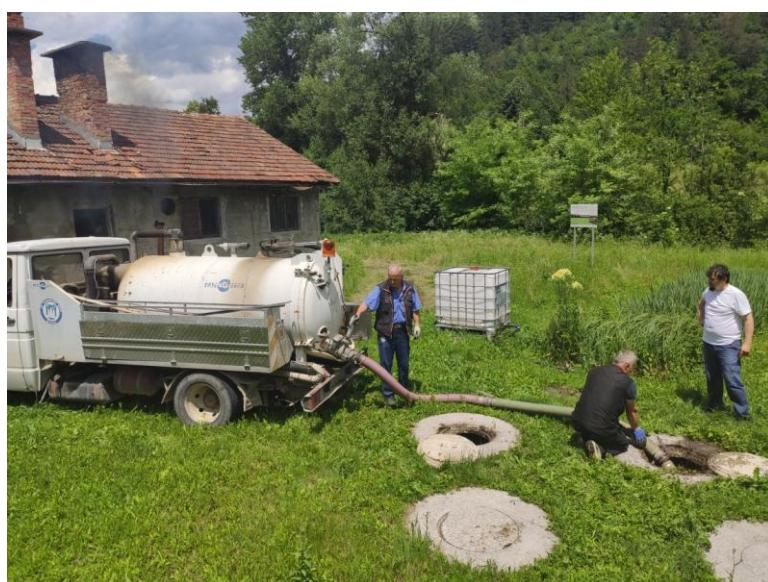
Slika 28. Čišćenje biljnog uređaja i priprema spremnika za sintetsku otpadnu vodu
