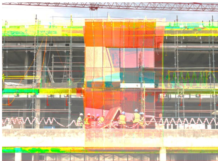
Ilustracija 40 – lijevo - proširena stvarnost pomaže graditeljima da pravilno postavljaju fasadnu oblogu; izvor: ShoP
