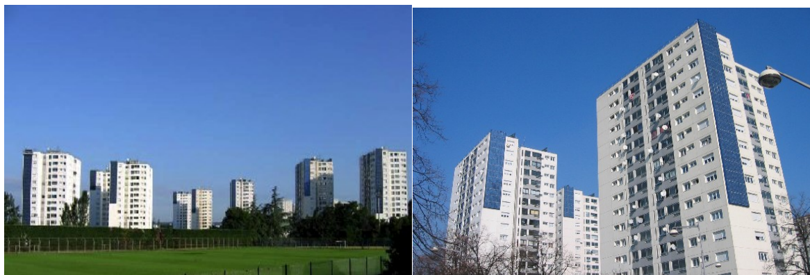
Slika 2.5. FN solarni sistem instaliran na fasade zgrada okruga La Darnaise, Francuska, ( www.pvupscale.org ) [26]
