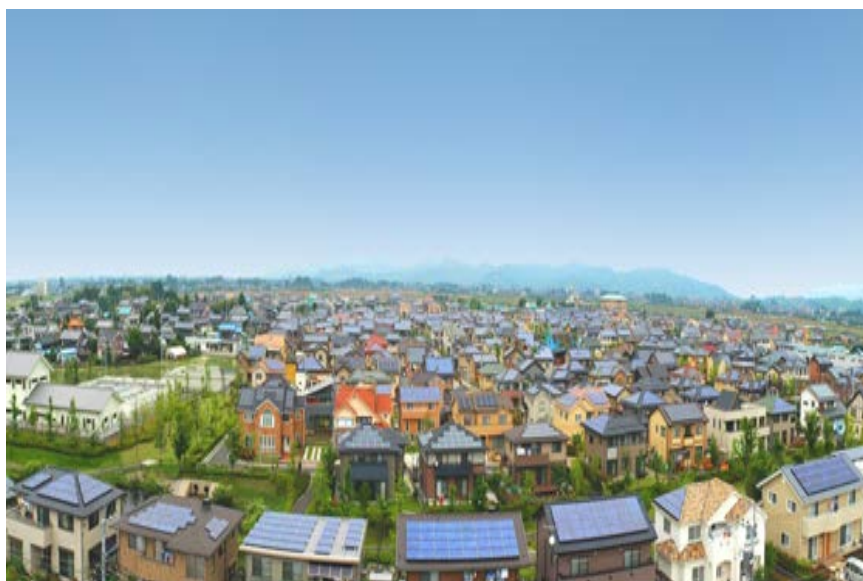
Slika 2.4. Solarni fotonaponski sistem instalirani na krovove kuća, stambenog kompleksa „Pal Town Josai-no-Mori”, u Ota City, Gunma Prefecture, u Japanu, ( www.pvupscale.org ) [25]
