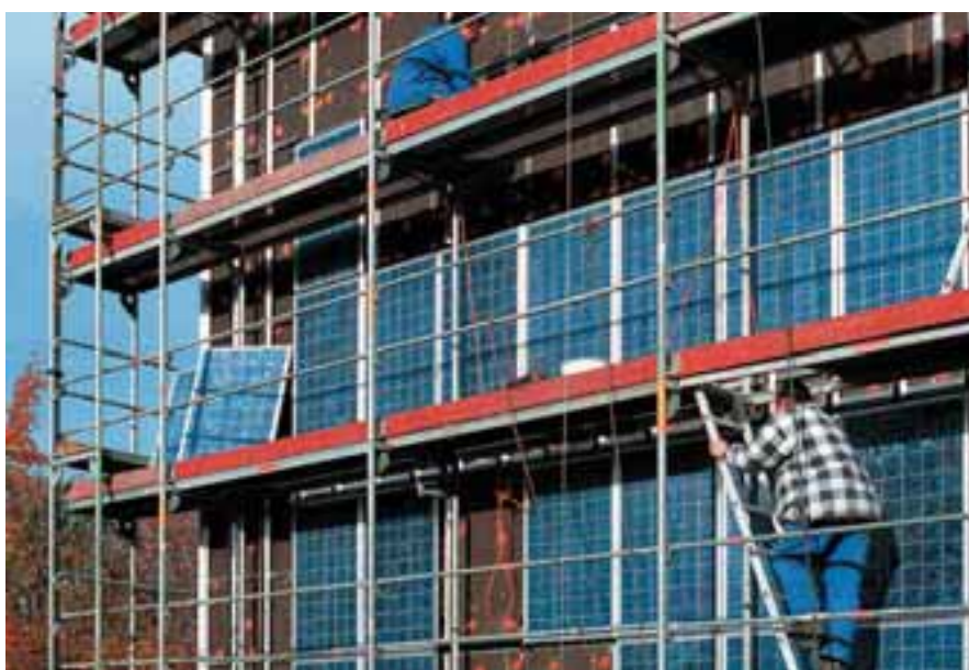
Slika 2.2. Montaža solarnih FN modula na fasadi zgrade (LEG) [ www.50-solarsiedlungen.de ] [24]
