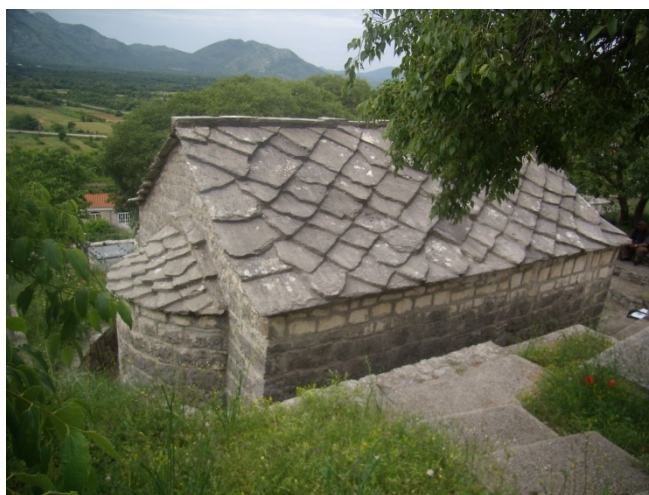
Сл. 2. Сјевероисточна страна цркве.
