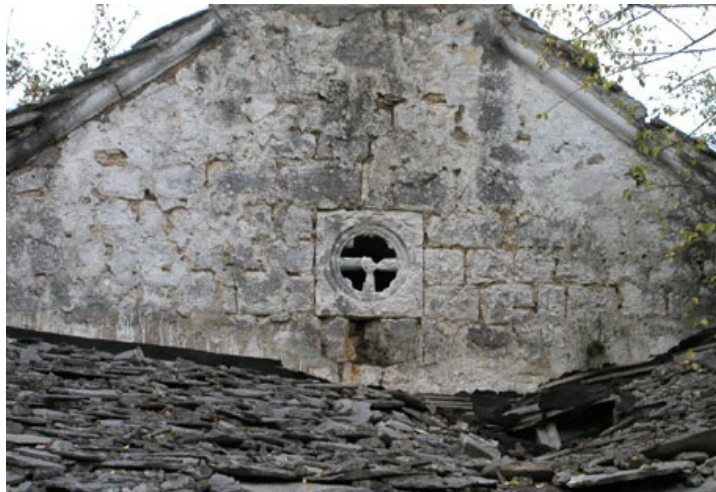
Сл. 4. Розета (прије обнове) западна страна. Извор: http://old.kons.gov.ba/main.php?id_struct=6&lang=1&action=view&id=1817
