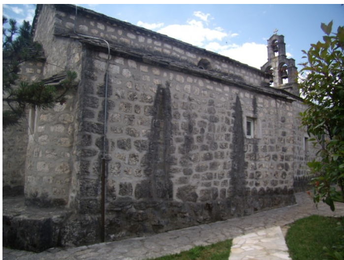
Сл. 3. Сјевероисточна страна цркве
