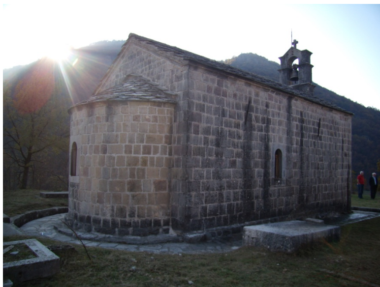
Сл. 3. Сјевероисточна страна цркве
