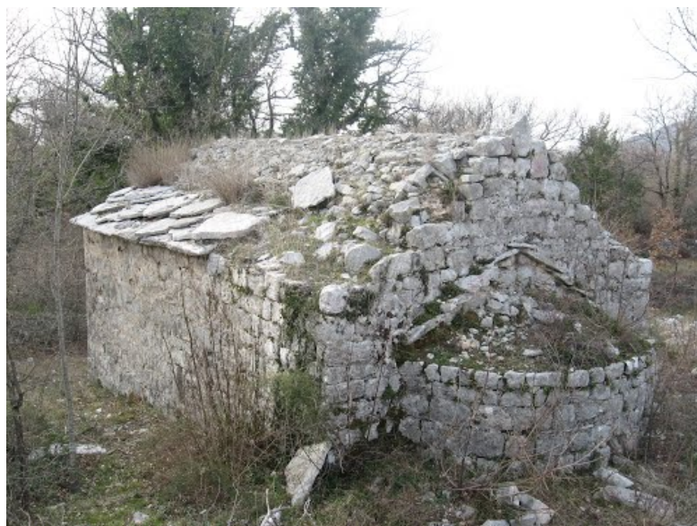
Сл. 3. Источна страна цркве
