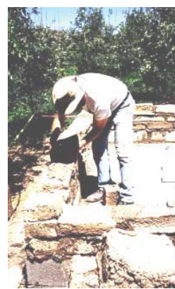
Slika 2.3. Gradnja kuće elementima sušenim na suncu spravljenim mešavinom papira i gline, malter je od papira i cementa (Izvor: http://www.greenhomebuilding.com .) 13
