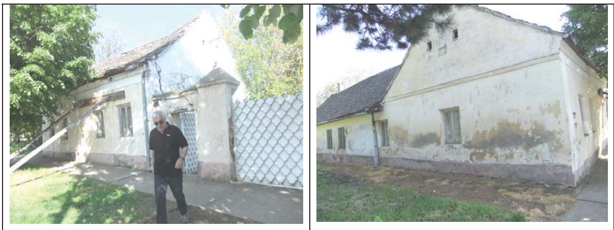
Slika 4.2. Postojeći objekat, prednji izgled, bočni izgled 4
