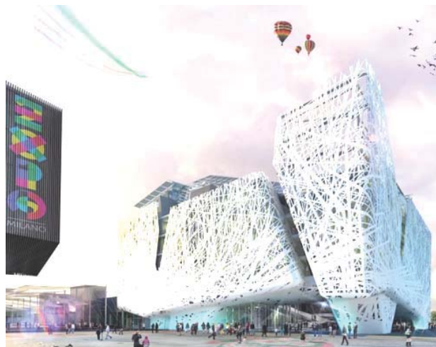
Slika 2.9. Italijanski paviljon na EXPO 2015. u Milanu, izgrađen od betona koji prečišćava vazduh (Izvor: decorinportal.com; https://www.tportal.hr/ )
