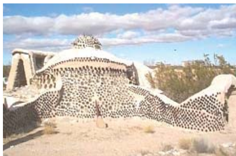
Slika 2.2. Jedna od kuća sagrađena od staklene ambalaže i maltera koji se spravlja od cementa i starog papira (Izvor: http://www.greenhomebuilding.com .) 12
