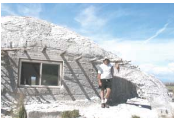
Slika 2.3. Gradnja kuće elementima sušenim na suncu spravljenim mešavinom papira i gline, malter je od papira i cementa (Izvor: http://www.greenhomebuilding.com .) 13
